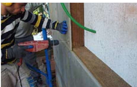
Realizzazione di angoli nel sistema per cappotto termico Betontherm fiber base
